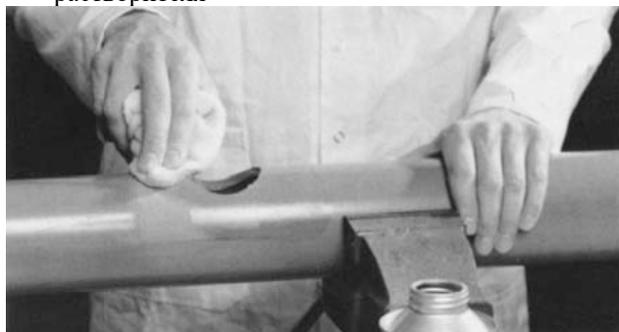
4. Наденьте на трубу два зажимных кольца с червячным приводом (Jubilee) которые прижмут опору к трубе опору во время схватывания клея. Зажимные кольца должны быть помещены по обе стороны седлового отвода. Нанесите растворитель на трубу и отвод. **Очень важно быстро наносить растворитель.**
