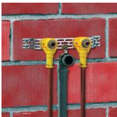
Монтаж умывальника: Точный монтаж по заданным размерам
