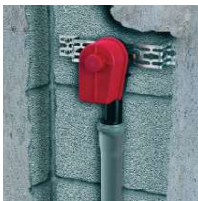
Монтаж в стене: Сифон для стиральной машины
