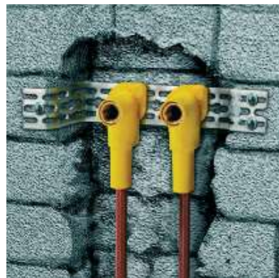
Монтаж умывальника: Монтаж в узких пазах в кладке стены
